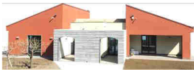
IL PARCO: C.da Piano dell'Acqua s.n., Zafferana Etna
